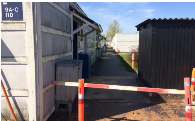
Kronen Vest - plader, udlagt over huller. Udførelse af vandledning 4.
